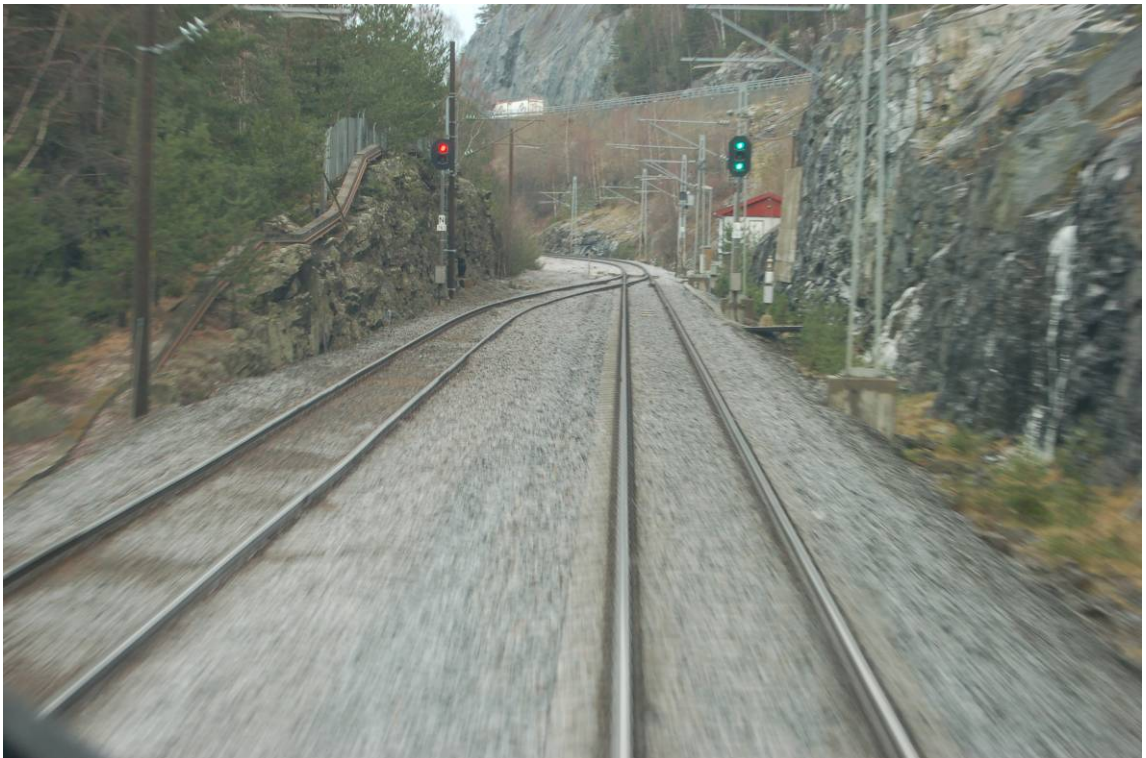
Figur 3: Molykkja stasjon sett fra sør mot nord.
