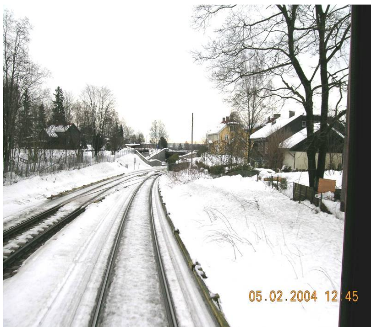
Figur 3: Innkjøring til Makrellbekken stasjon mot Oslo.
