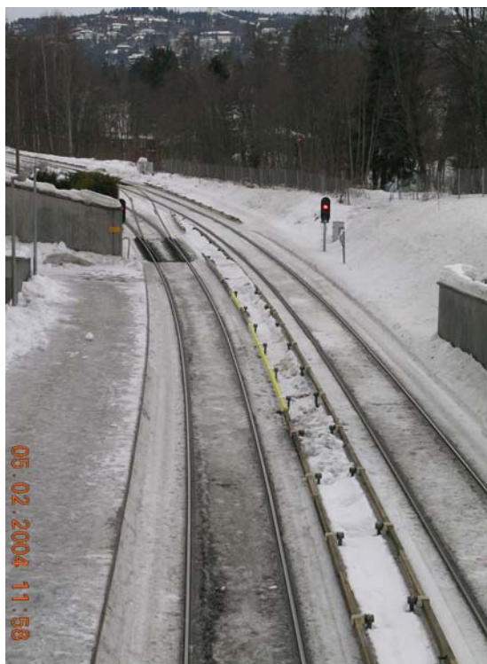
Figur 1: Makrellbekken T-banestasjon sett i retning fra Oslo. Snøen ble brøytet mot muren av den ene traktoren. Den andre traktoren freste snøen over muren. T-banetoget kom kjørende inn på stasjonen i venstre spor, mot Oslo.
