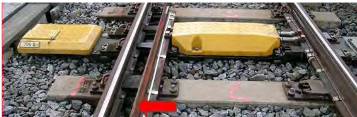
Figur 2: Drivmaskin 706B. Sporvekseltunga lå i samme posisjon (til rettspor) som vist på bildet og ble presset til venstre under oppkjøringen. Foto: SHT
